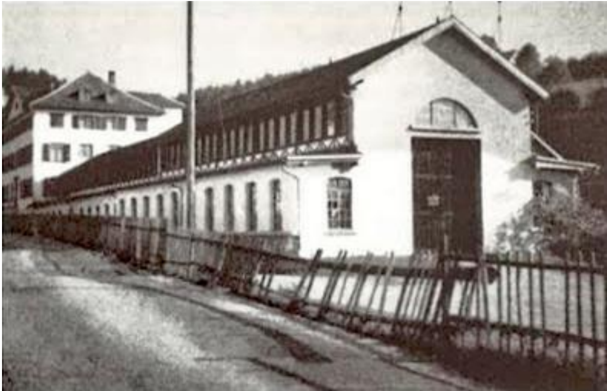
Abbildung 18 Die Fabrikhalle von Westen 1953
